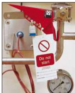
Låst kuleventil + Varselskilt
